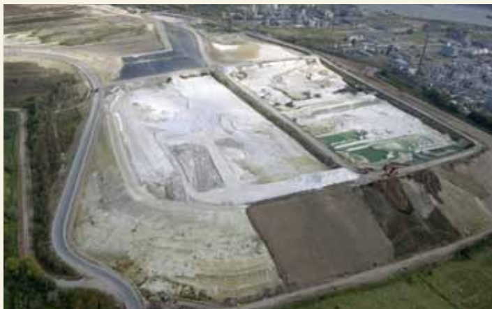
Foto van het zuidelijk deel van de stortplaats (sept 2011)
