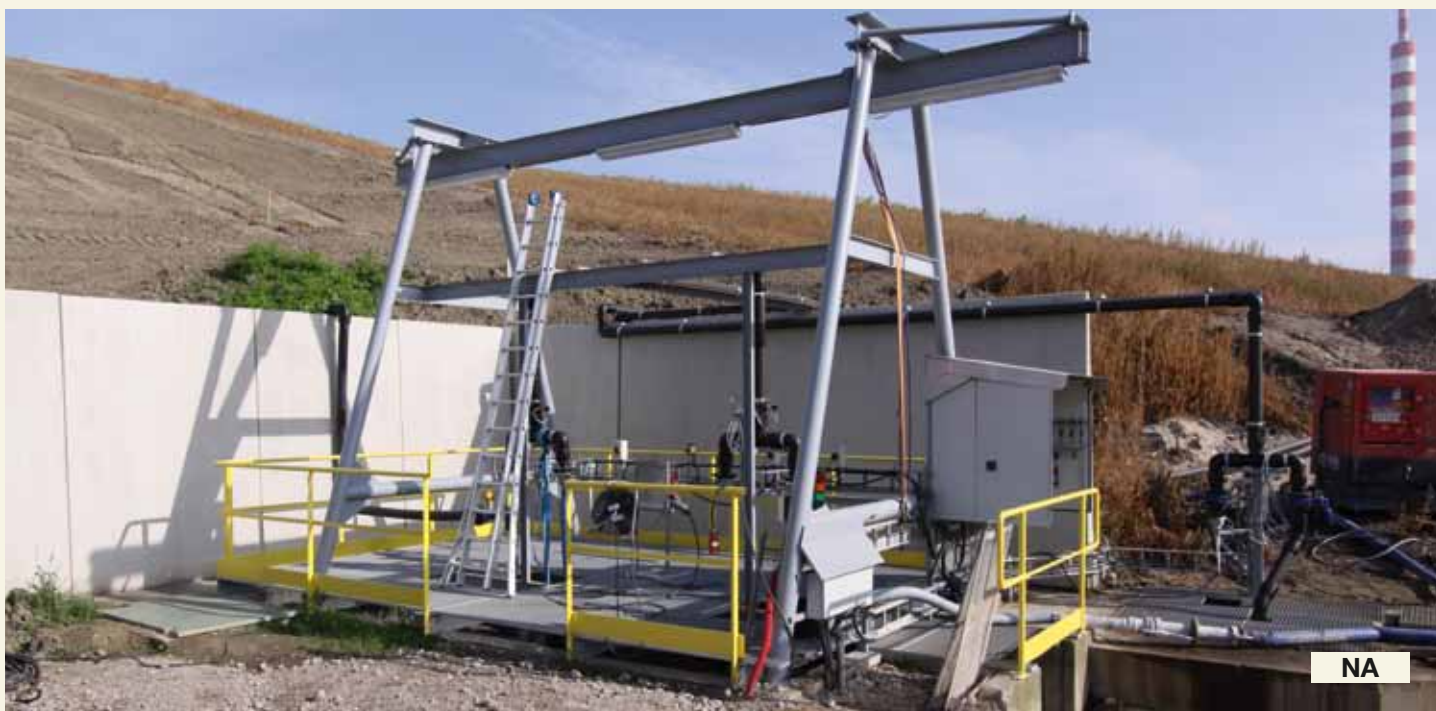
Vernieuwing van een pompstation: voor (juli 2010) en na (juli 2011)
