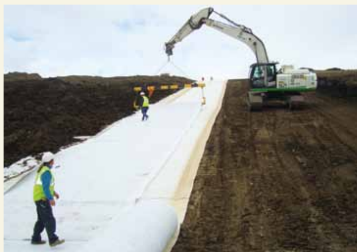
Afdekken van de gipsberg met kleimatten en een grondlaag (sept 2011)
