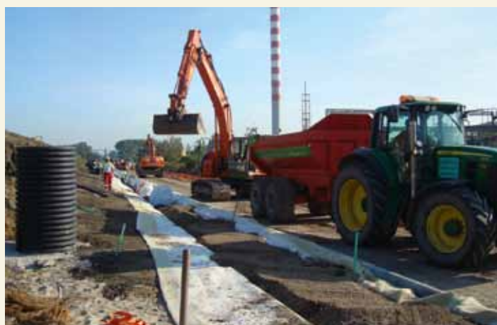
Aanleg van de waterafvoer rondom de gipsberg (aug 2011)
