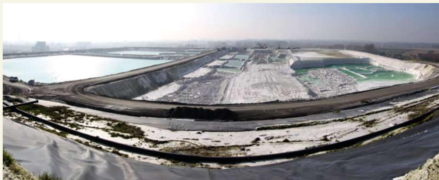
Zuidelijke zone van de gipsberg (februari 2011)
