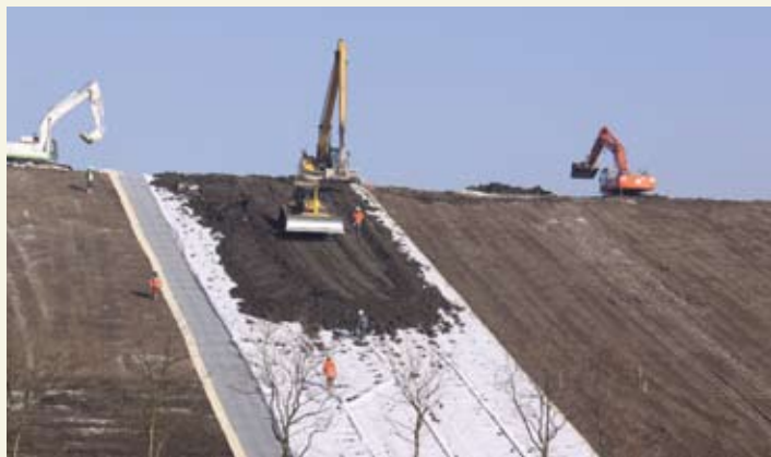
Afwerken van de zuidelijke hellingen (februari 2011)
