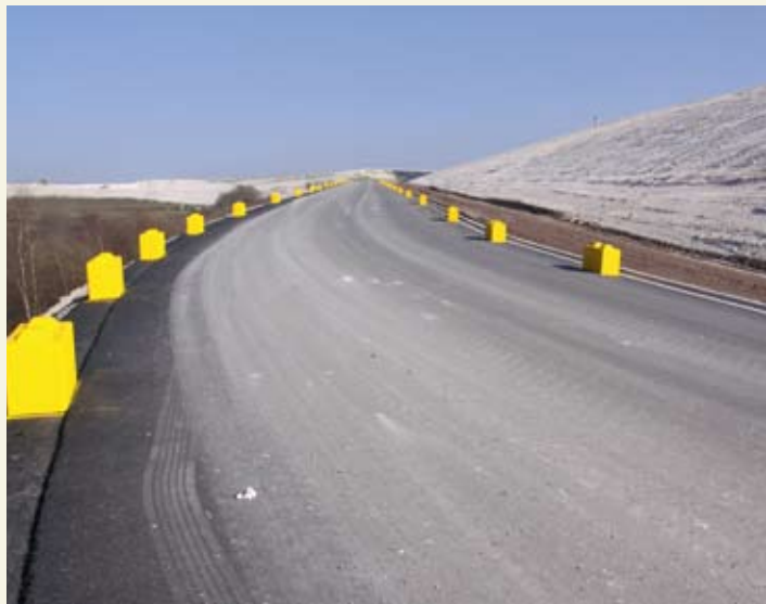
De nieuwe toegangsweg tot de gipsberg
